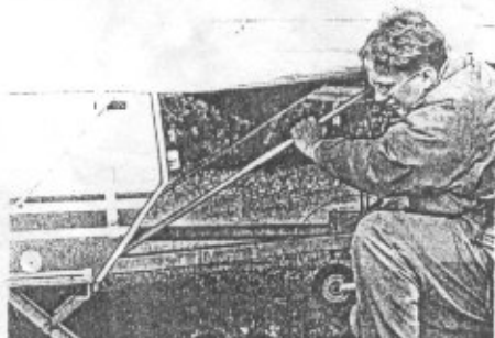
Het aanbrengen van de steunstocken onder de bedplanken.
